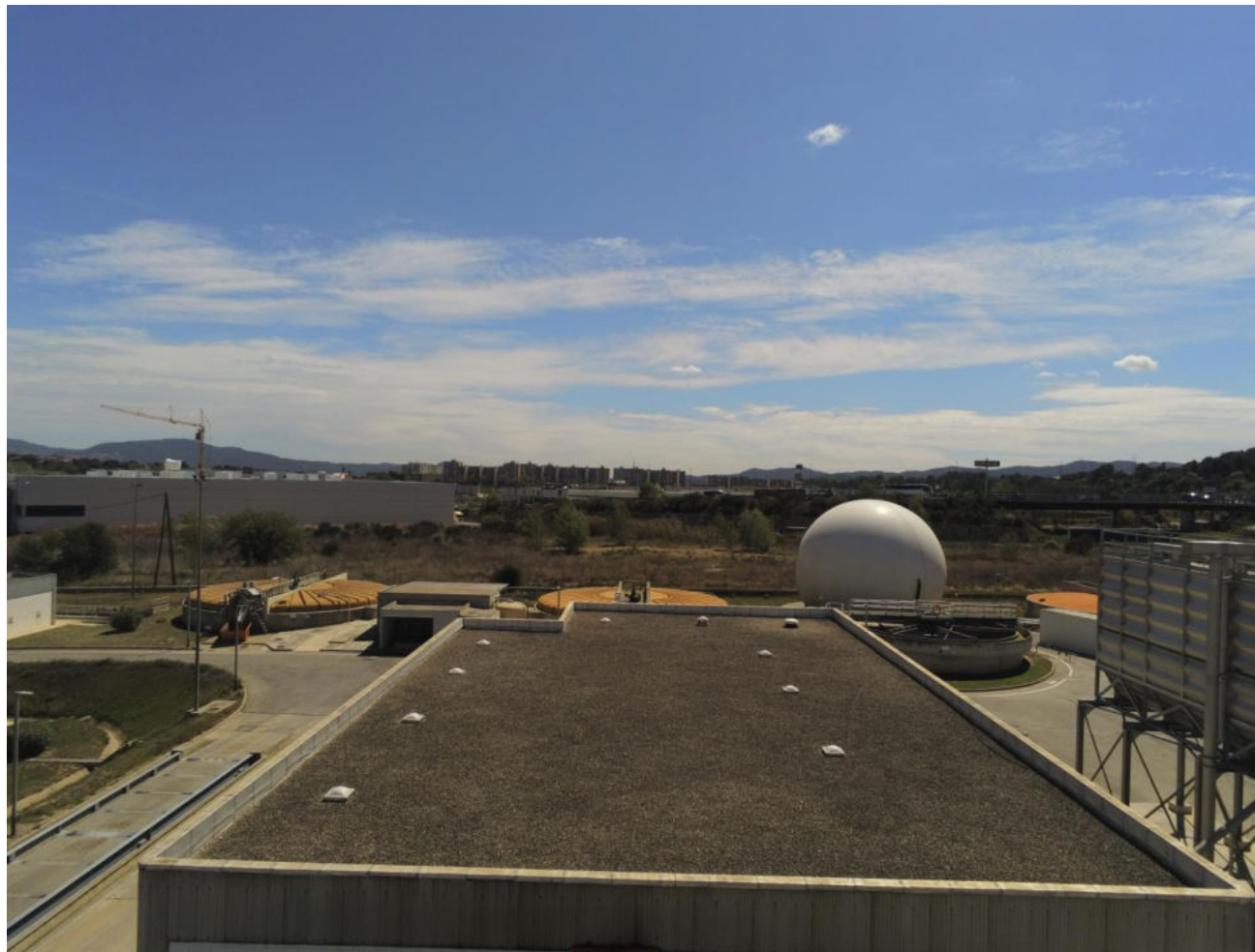
Figura 1. Coberta de l'edifici d'assecat
