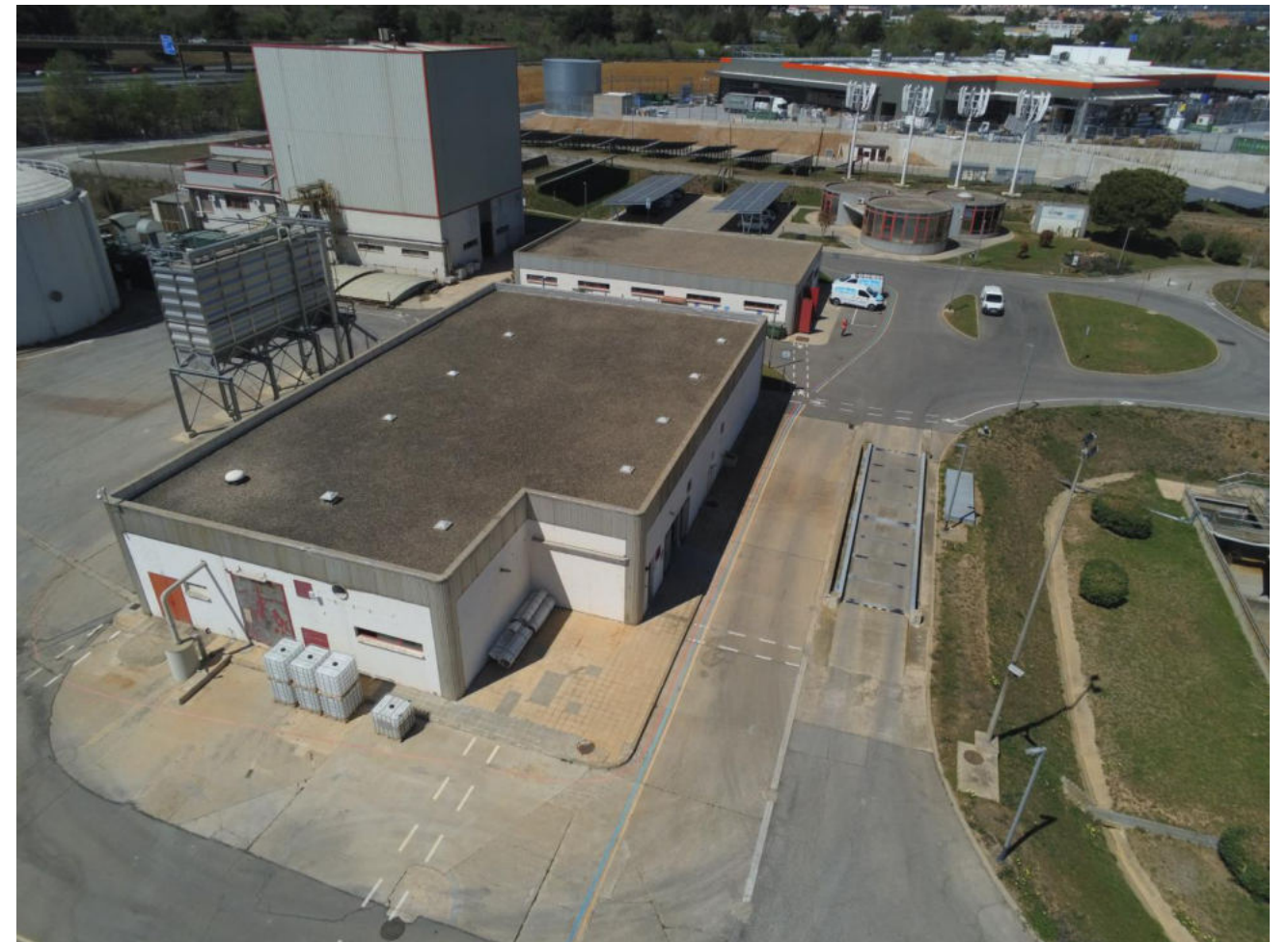
Figura 2. Vista aèria de l'edifici d'assecat, al front, i el taller-vestidors, al fons.
