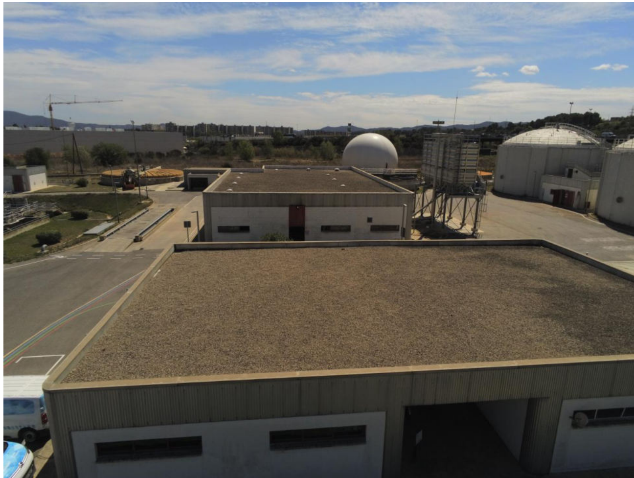
Figura 3. Vista aèria del taller-vestidors, al front, i l'edifici d'assecat, al fons.
