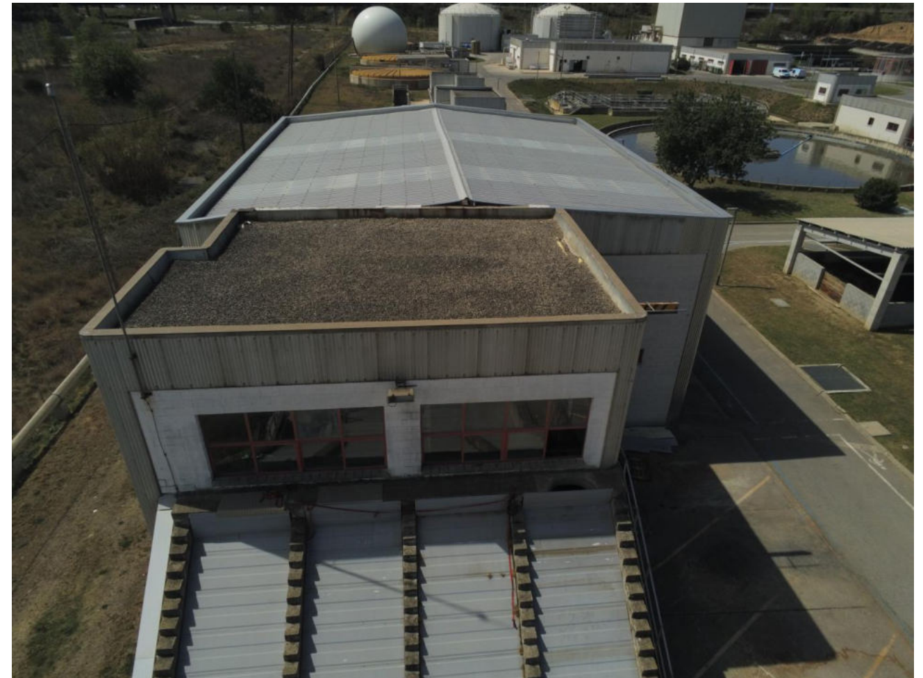
Figura 4. Vista aèria dels edificis de desbast
