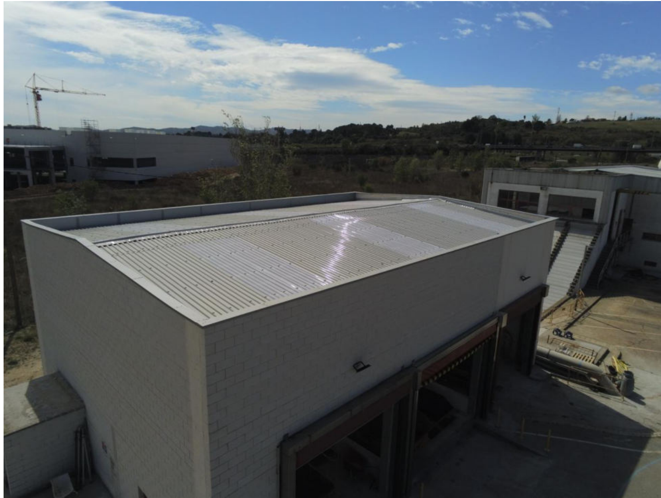
Figura 5. Coberta del pou de gruixuts. Al fons dret, els edificis de desbast.
