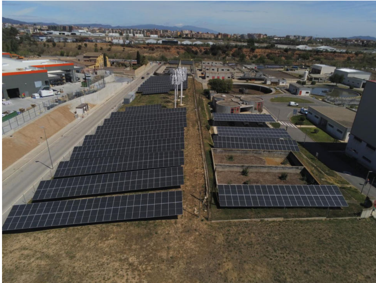
Figura 7. Vista general del conjunt de plaques de la fase 1.
