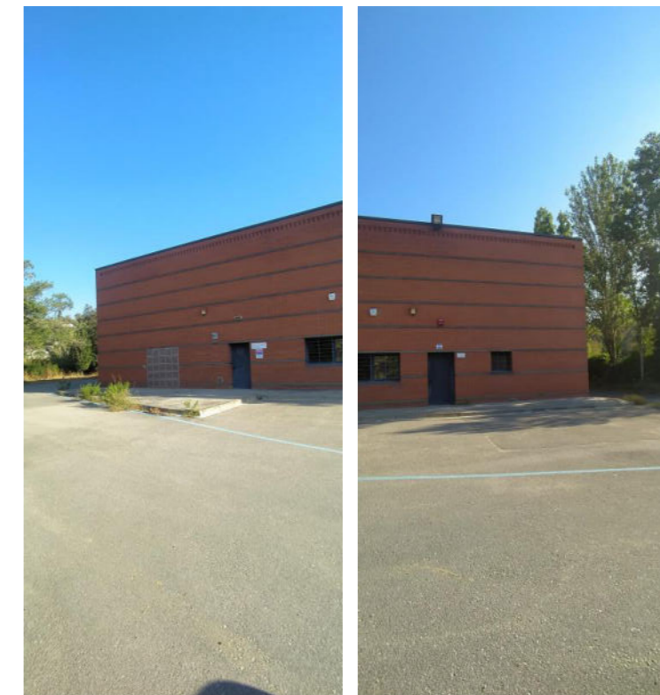
Figura 6. Zona d'accés a l'EBAR Sant Oleguer
