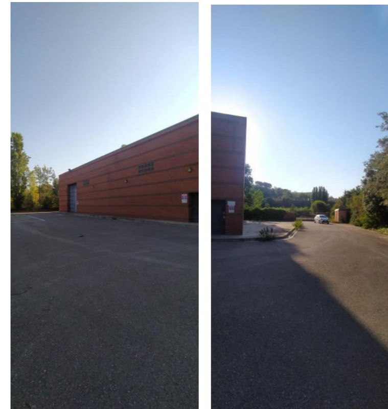
Figura 5. Zona d'entrada a l'EBAR Sant Oleguer
